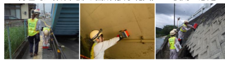
道路の狭小部(歩道)
