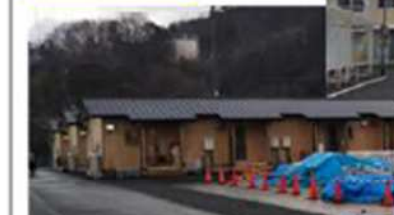
応急仮設住宅 （左）プレハブ住宅 （上）コンテナ住宅 応急借上げ住宅など
