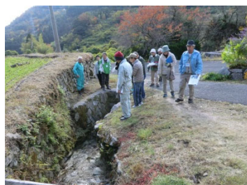
現地での危険箇所確認
