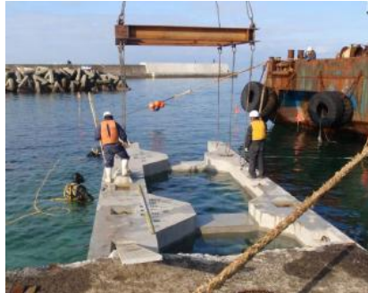
青森県 源氏ヶ浦漁港（ユニット据付時）
