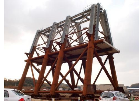
長崎県 阿翁浦漁港（ジャケット製作時）
