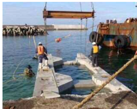
青森県 源氏ヶ浦漁港 (ユニット据付時)
