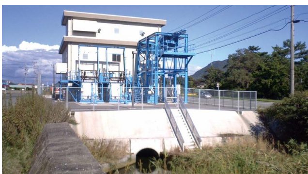
中関第二ポンプ場（防府市）
