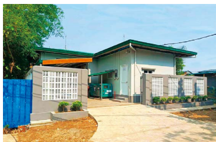
完成した施設の状況 ヤンゴン市ノースオカラッパタウンシップ
