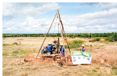
全国送電網開発プロジェクトにおける 土質調査業務 マンダレー地域メイッティエラ市
