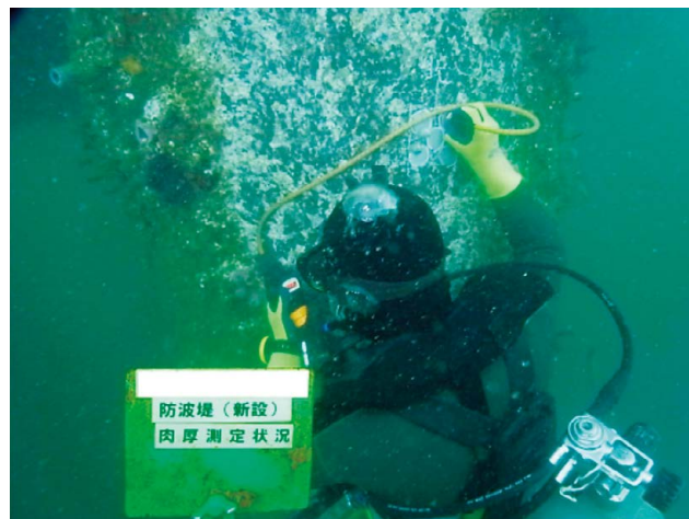
ダイバーによる港湾施設の潜水調査(健全度評価)
