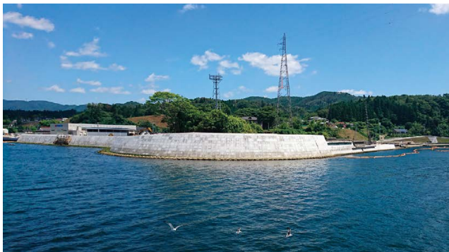
津波防潮堤（宮城県）
