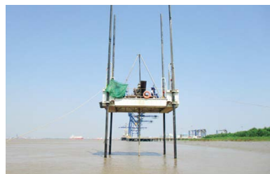
1,250MW LNG発電所建設に伴う 技術支援業務 ヤンゴン市ティラワ港湾エリア Plot 27,28,29
