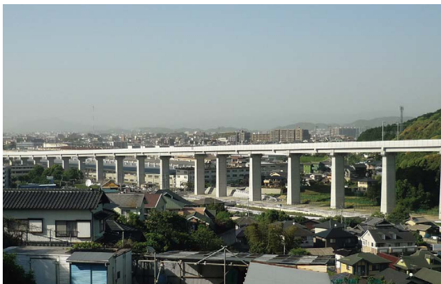
九州新幹線那珂川高架橋（福岡県） 橋脚高さ30m以上の連続した桁式高架橋の詳細設計。桁の製作ヤードが近くないため、移動式型枠による橋上製作のPCT桁として計画。
