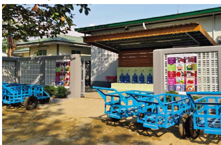
完成した施設の状況 ヤンゴン市ダコンセイカタウンシップ
