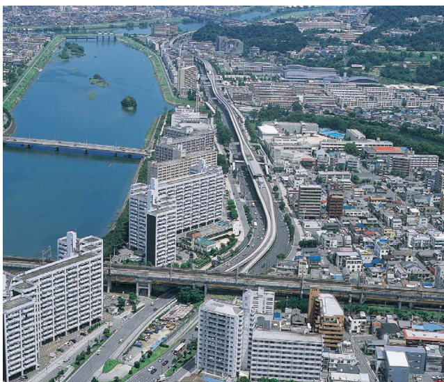
アストラムライン（広島県） 1994年開催の広島アジア大会のための交通インフラとして整備された新交通システム。弊社は、駅舎や高架橋の一部を設計。
