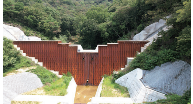
砂防堰堤（広島県）
