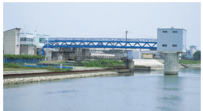
鳴門市取水施設（徳島県）
