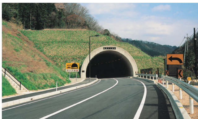
一般国道375号 熊見トンネル（広島県）
