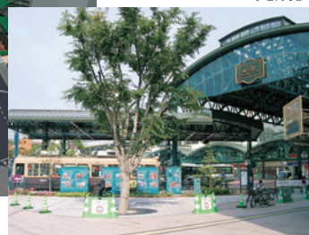
横川駅交通結節点 完成後
