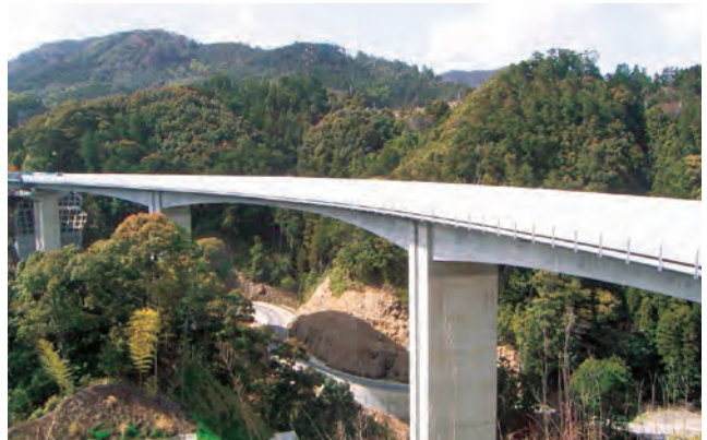
清水谷第一高架橋（和歌山県）
