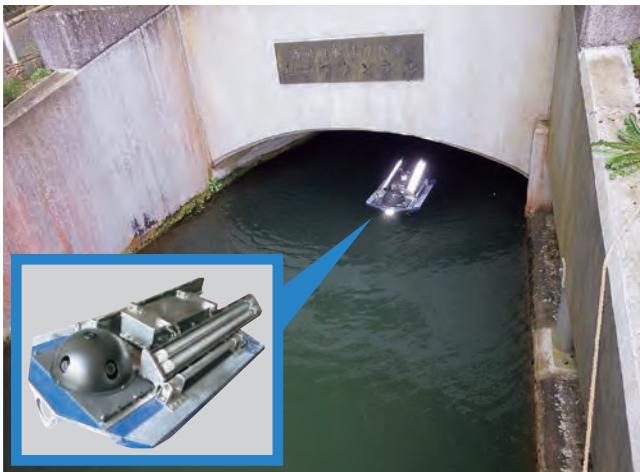
水路トンネル内面調査 (調査ロボットによるビデオ撮影～健全度評価)
