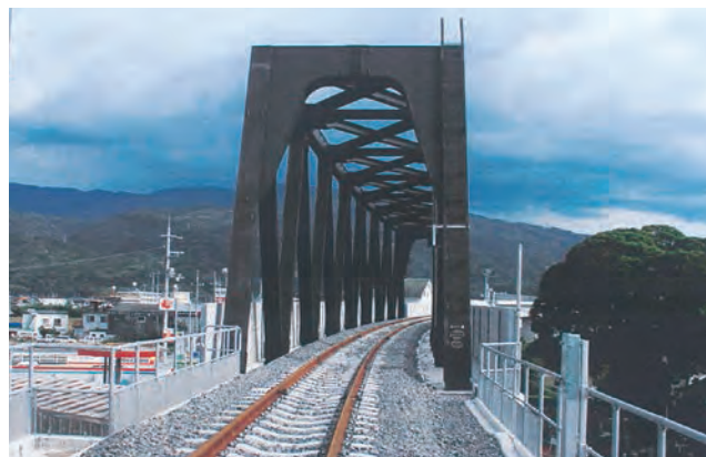
土佐くろしお鉄道 第5田野高架橋 (高知県)
