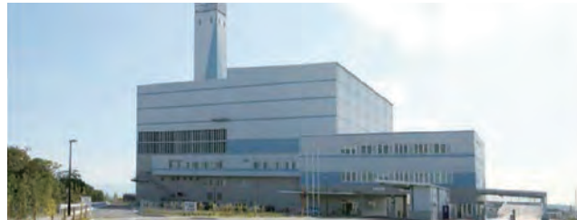
大阪府堺市 廃棄物発電事業
