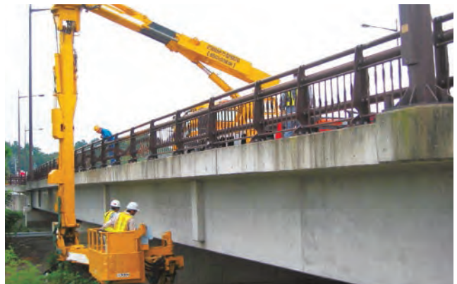
橋梁定期点検業務（四国地方整備局）
