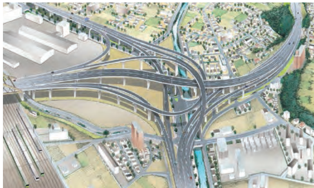
広島高速2号線・温品JCT（広島県）
