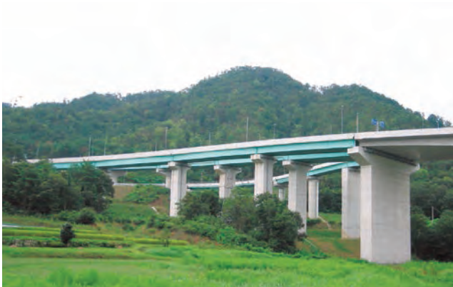
志和インター線橋梁（広島県）
