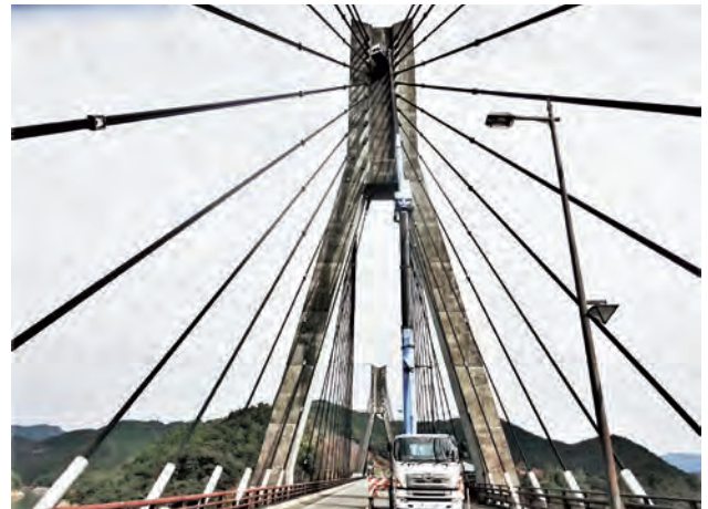
橋梁定期点検 (高所作業車による近接目視)
