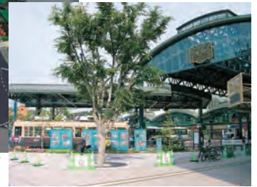
横川駅交通結節点 完成後
