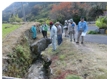
現地での危険箇所確認
