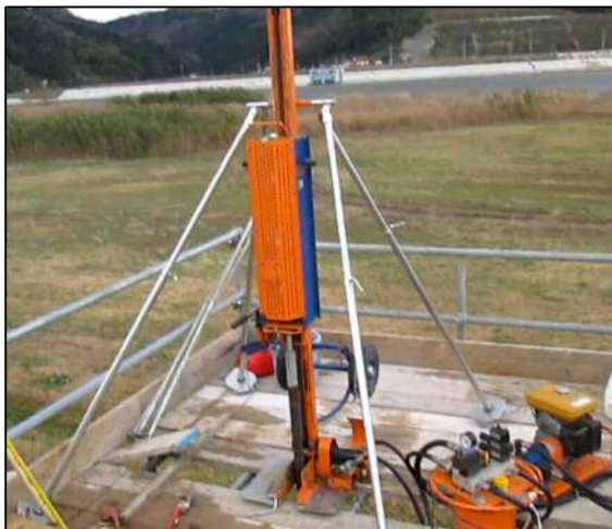
写真-1 動的貫入試験装置 (ミニラム) (透水試験器具を打撃貫入中)
