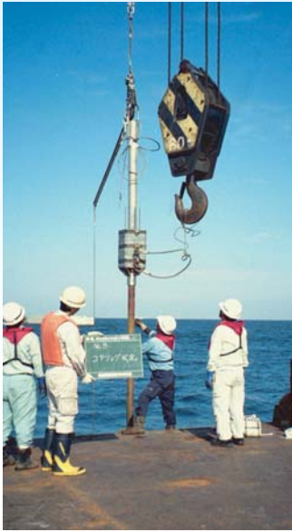
コアラ投入状況
