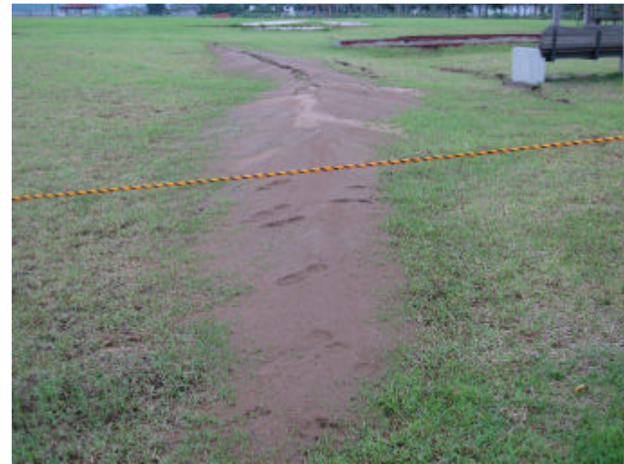
公園内の芝生に発生した噴砂
