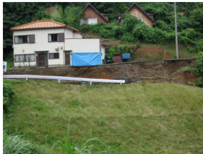
笠島駅南側道路の崩壊
