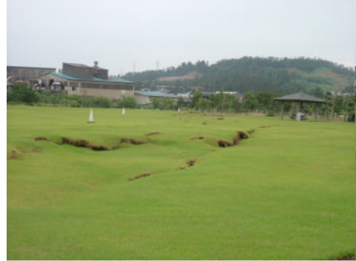
公園内の芝生広場に発生した段差
