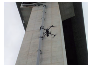
ドローンによる高橋脚点検
