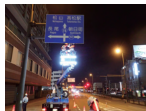
高所作業車による道路標識点検
