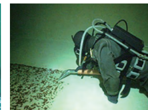
ダイバーによる調整池の清掃・調査
