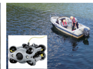
水中ドローンによるダム躯体調査
