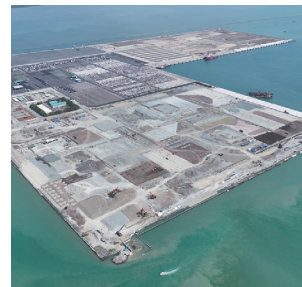
Patimban港建設状況
