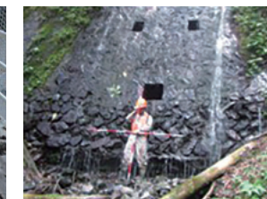
砂防施設点検
