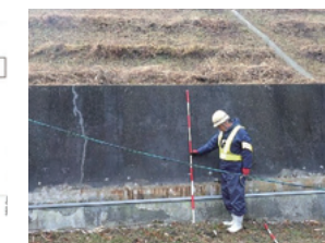
既存盛土現地調査
