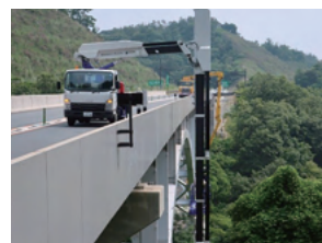
橋梁点検車による橋梁点検
