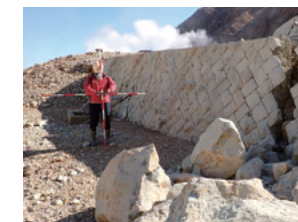
地すべり施設点検
