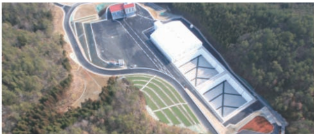
岡山県新見市 一般廃棄物処理施設整備事業
