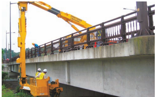
橋梁定期点検業務（四国地方整備局）
