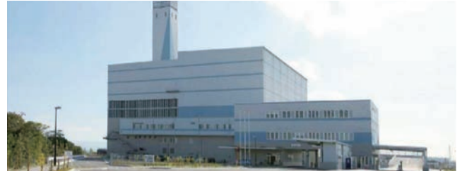
大阪府堺市 廃棄物発電事業
