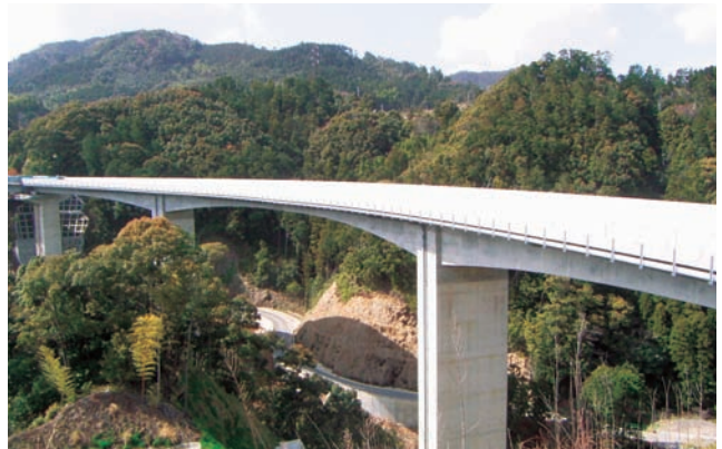
清水谷第一高架橋（和歌山県）
