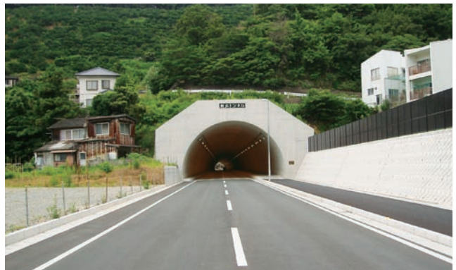
国道378号 朝立トンネル（L=387m）（愛媛県）
