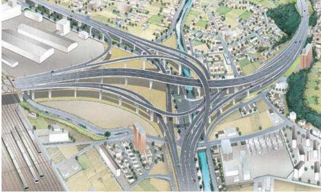
広島高速2号線・温品JCT（広島県）
