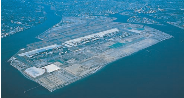
東京国際空港沖合展開事業への参画（昭和62年～現在：東京都） 超軟弱地盤上での空港建設のための地盤改良計画・設計・解析及び情報化施工。 （平成7年旧運輸省第二港湾建設局長表彰）
