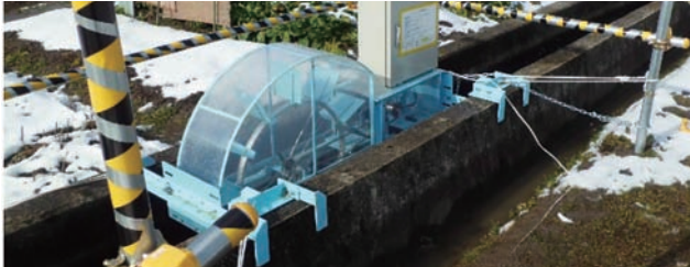
広島県三次市 小水力発電実証事業
