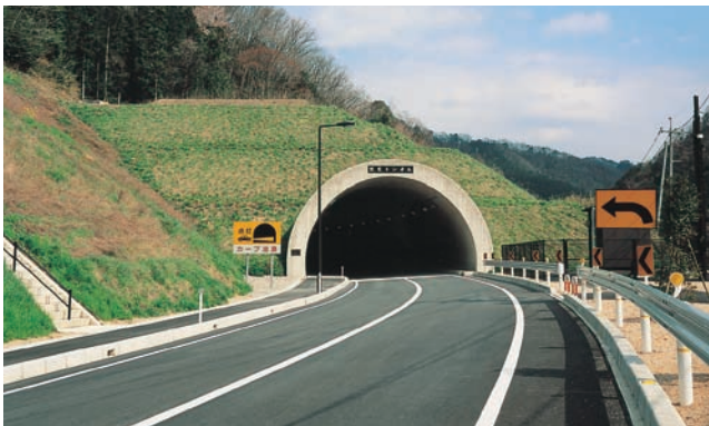
一般国道375号 熊見トンネル（L=732m）（広島県）
