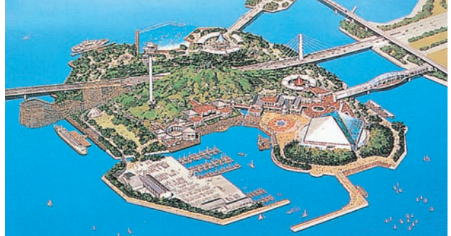
金沢地区海の公園八景島事業への参画（昭和59年～現在・横浜市） 人工島築山建設（海面上20m）における護岸安定管理及び埋立地内圧密沈下管理のための情報化施工
