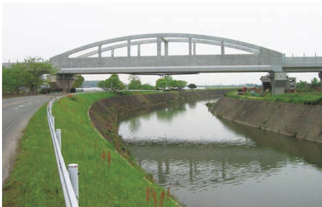
九州新幹線 飯江川橋梁 (福岡県)
