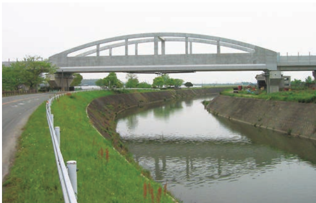
九州新幹線 飯江川橋梁 (福岡県)
