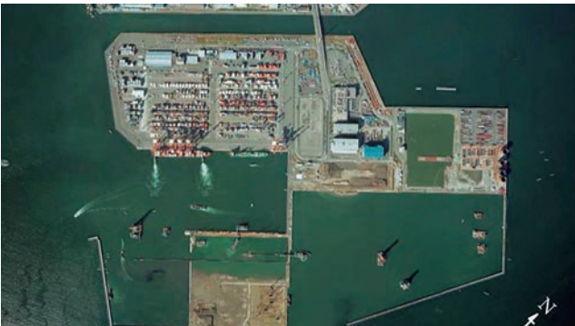
南本牧ふ頭整備（神奈川県） 横浜港南本牧ふ頭は、増大するコンテナ貨物や大型化する船舶に対応するため、水深16mのわが国最大級にコンテナバースを備えています。
