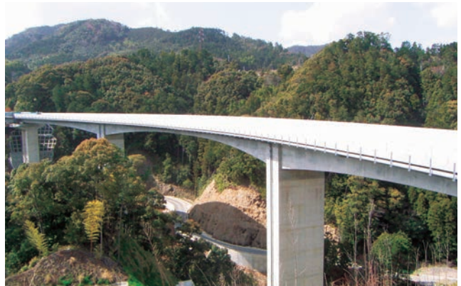
清水谷第一高架橋（和歌山県）
