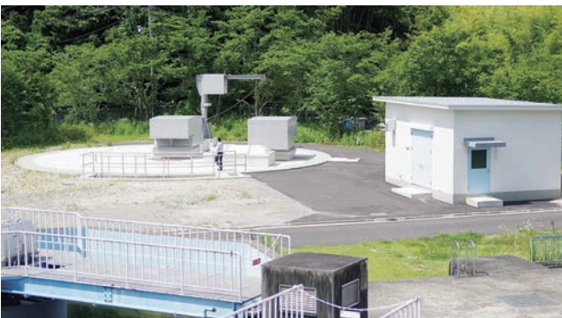
高陽系・戸坂系連絡管整備事業（広島県） 緊急時を含めた相互水運用を可能とするため、2系統の導水トンネルを連絡する連絡管、導水ポンプ施設などの計画・設計を行ったものです。計画導水量80,000m 3 /日の施設で、導水ポンプ場はニューマチックケーソンで構築した内径16m、深さ15mの地下3階構造になっています。（H26全建賞受賞事業）
