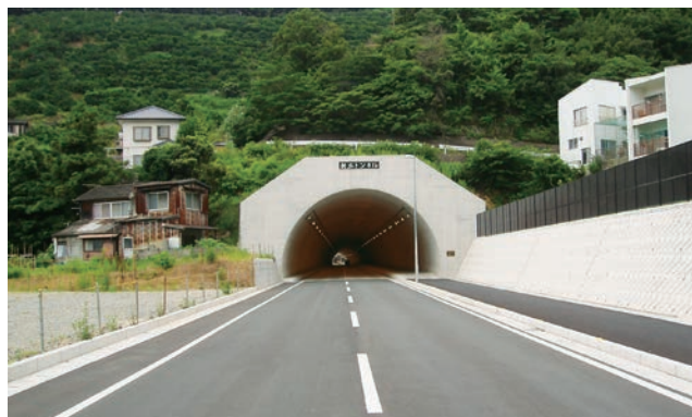
国道378号 朝立トンネル（L=387m）（愛媛県）
