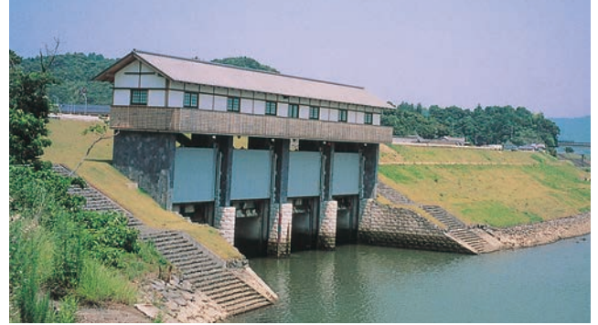
実崎樋門（高知県） 日本最後の清流と言われる四万十川において、計画・設計した幅6.5m×高さ4.5m×4連の大型樋門です。景観との調和を図り、土佐の伝統的民家の形式である漆喰造りをイメージしています。
