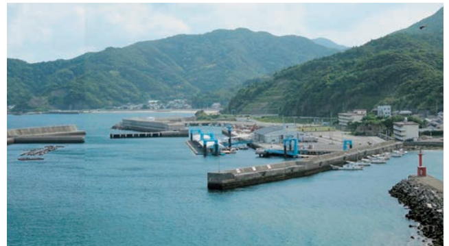
佐賀関漁港整備（大分県） 大分県佐賀関漁港は、衛生管理型漁港として、生け簀付き浮体式係船岸や海水交換型防波堤が整備されています。（H23全建賞受賞事業）
