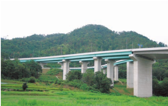
志和インター線橋梁（広島県）
