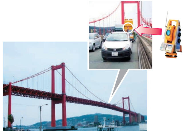
長大吊橋における形状計測 (MAT計測法「若戸大橋」)
