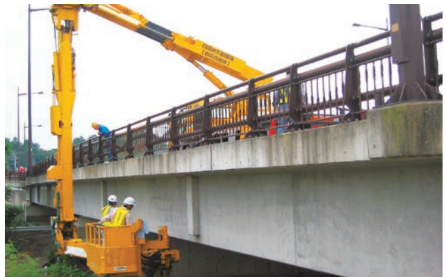
橋梁定期点検業務（四国地方整備局）
