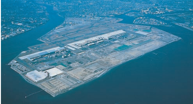
東京国際空港沖合展開事業への参画（昭和62年～現在：東京都） 超軟弱地盤上での空港建設のための地盤改良計画・設計・解析及び情報化施工。 （平成7年旧運輸省第二港湾建設局長表彰）
