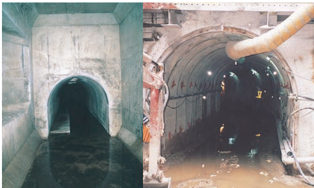
千森川放水路3号取込工 送水トンネル（L=147m）（兵庫県）
