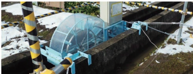
広島県三次市 小水力発電実証事業
