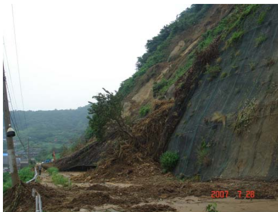
地震時に発生した斜面崩壊 (2007年 新潟中越沖地震)
