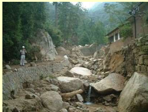
平成 17 年台風 14 号災害 (広島県廿日市市宮島町白糸川)
