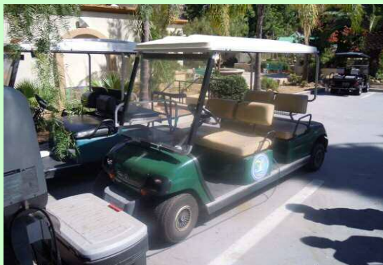
ゴルフカート用の充電施設
