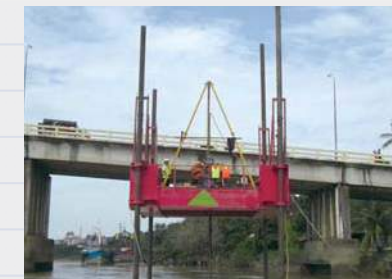
現地スタッフによる海上ボーリング
