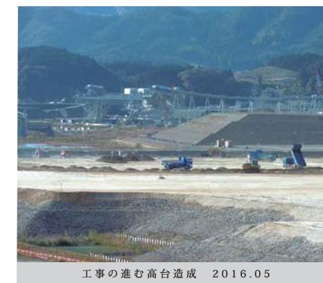
工事の進む高台造成 2016.05
